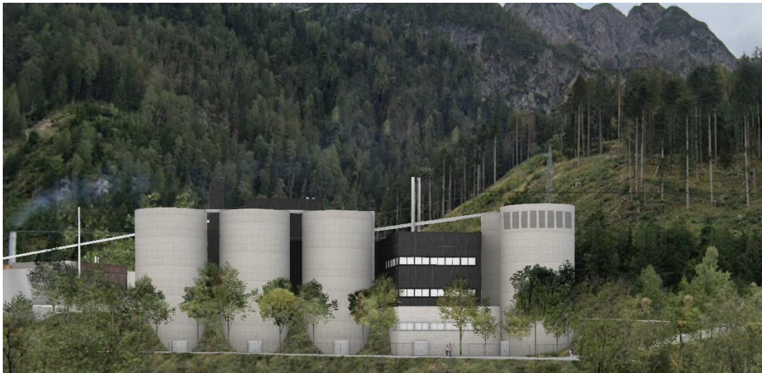
Ab 2026 wird die KWK-Anlage und das Pelletwerk in Betrieb genommen.
